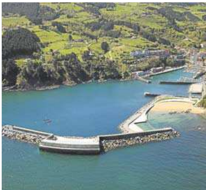
Dique de abrigo del puerto de Mutriku, donde está la planta undimotriz.
