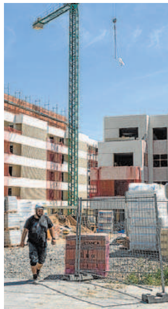
Obras en Aretxabaleta. IGOR MARTÍN
