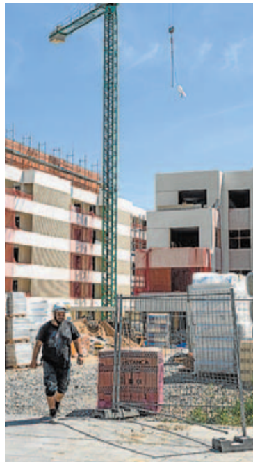
Obras en Aretxabaleta. IGOR MARTÍN
