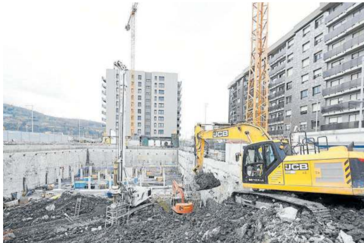
Obras de construcción de una promoción de VPO en Bilbao. Foto: José Mari Martínez
