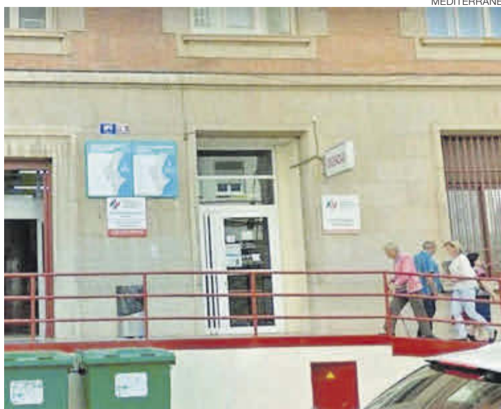
Acceso a Urgencias del Centro de Especialidades Jaume I de Castelló.
