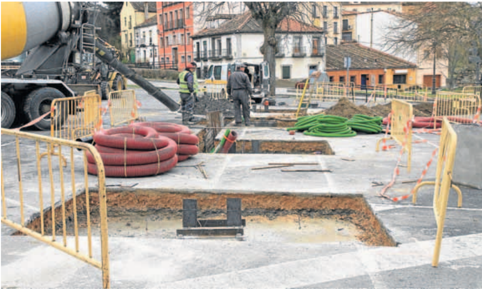
Obras para la instalación de la electrolinera, que se ubicará en la parte central del aparcamiento de Puerta de la Reina. :: ANTONIO TANARRO
